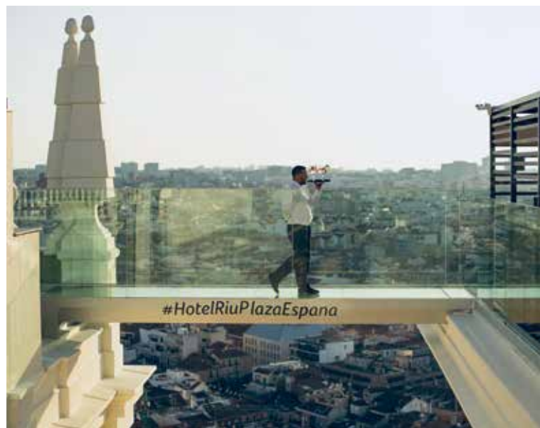
Sopra, passerella pedonale, nell'hotel Riu Plaza di Madrid, laminata con AB-ARw
